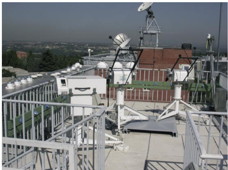
Estación Radiométrica en el CRN (Sede Central de AEMET).
