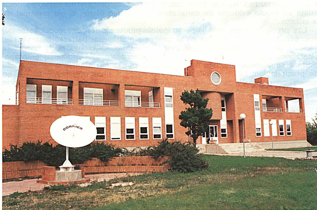
Vista frontal del Centro
