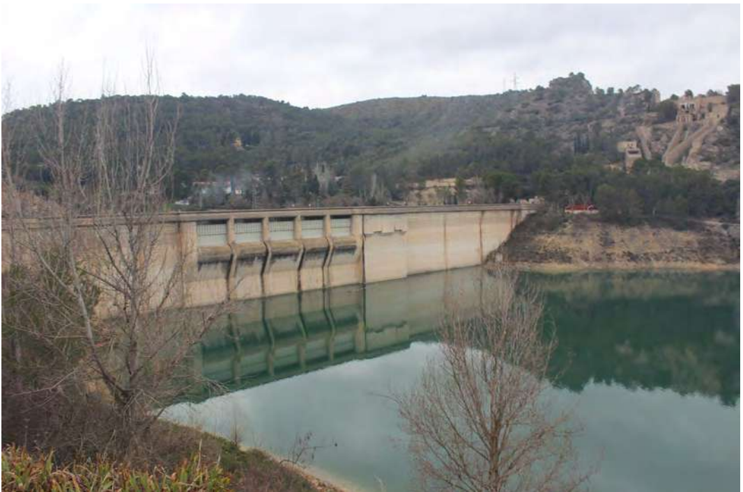
Presas del embalse de Entrepeñas cuando el nivel del agua estaba a poco menos del 40 % de su capacidad total. Sacedón, Alcarria de Guadalajara, 27 de enero de 2020.
